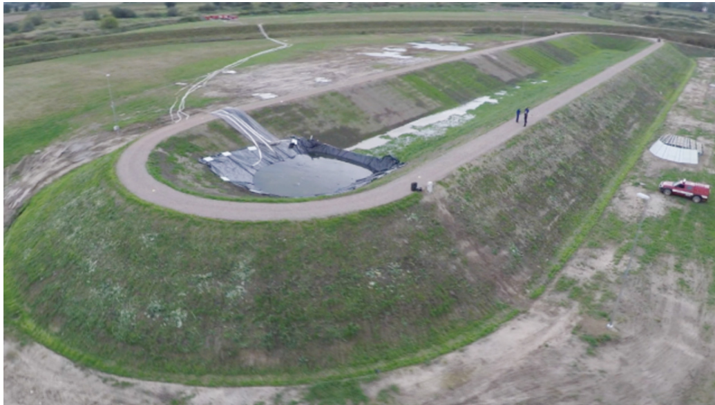
Fig. 2. ISMOP experimental levee (Oct 2015).
